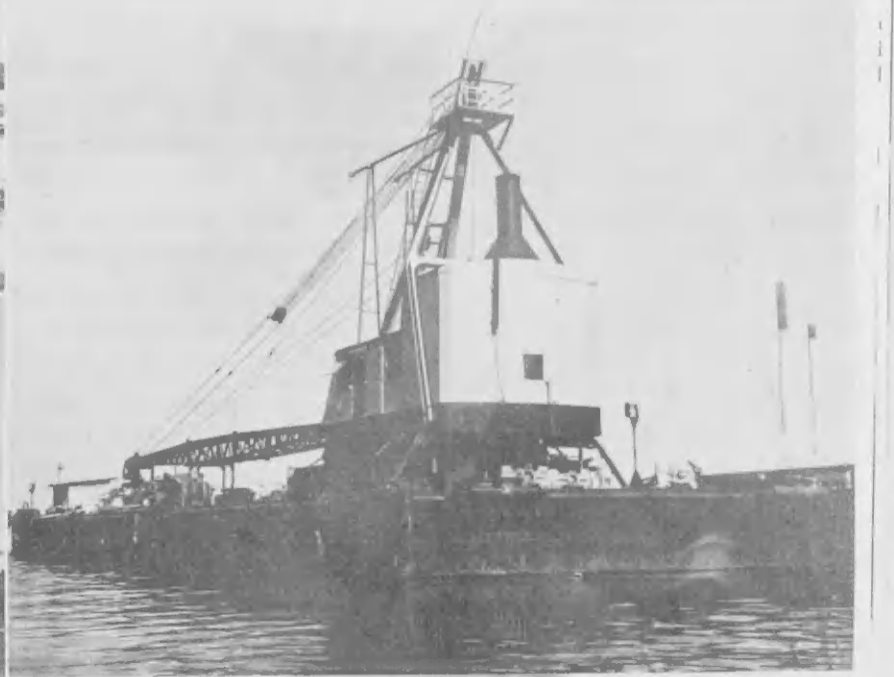
PREPARACIONNAN PA construcion di Finger Pier No. 3 nobo di Lago ta avanzando rapidamente. Cerca di lugarnan di entrenamiento contra candela un sitio pa sandblast ta worde prepará pa e contratista, Raymond Concrete Pile Company. Santa Sofia a trece algun di e pilones y na barge dock un di e gruanan grandi di e contratista ta spera.
